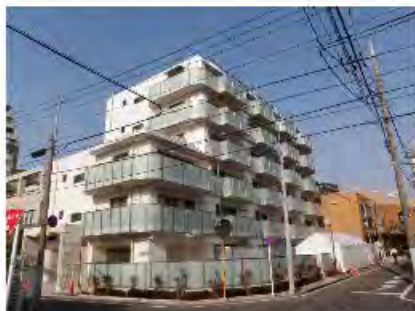
【JSPAC耐震工法による耐震補強後】
