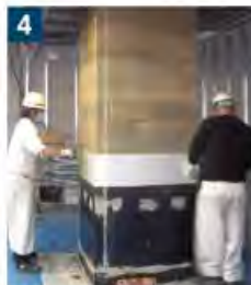
JSPACグラウト材充填 仕上げ
