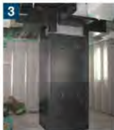
鋼板の段差修正 耐震補強JSPAC繊維シート貼付
